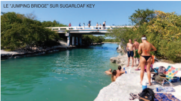
LE "JUMPING BRIDGE" SUR SUGARLOAF KEY
