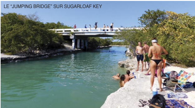
LE "JUMPING BRIDGE" SUR SUGARLOAF KEY
